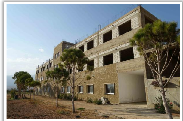
Bâtiment de l'école de Jabboulé. On voit les parties inachevées avec les classes qu'il s'agit de terminer.
